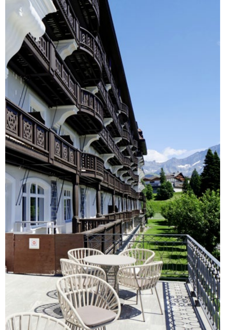
Un gros travail a été effectué sur les façades pour leur redonner tout leur éclat : l'enveloppe a été entièrement refaite et les fenêtres historiques ont été restaurées.
